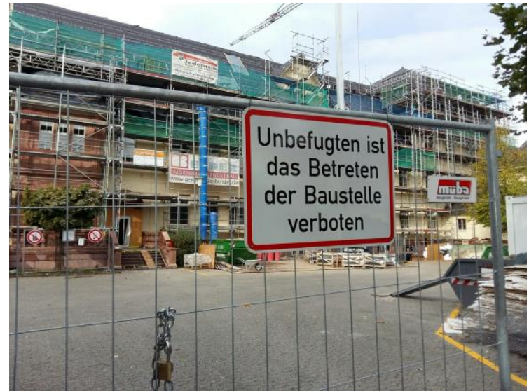
Im Nordteil des Altbaus wirken die Handwerker.
